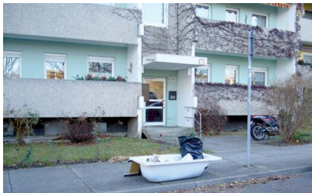
Häufigste Maßnahme für altengerechtes Wohnen – Ausbau der Badewanne für den Einbau einer Dusche (Foto: Rico Schubert)
