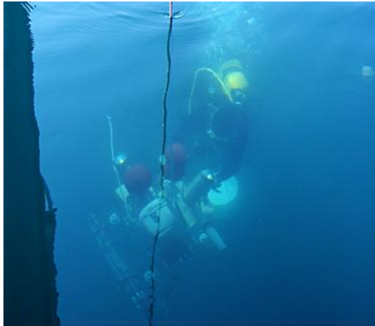
Das Gerät wird vom Taucher in Empfang genommen, von der Leine losgelöst und zum Meeresboden gebracht
